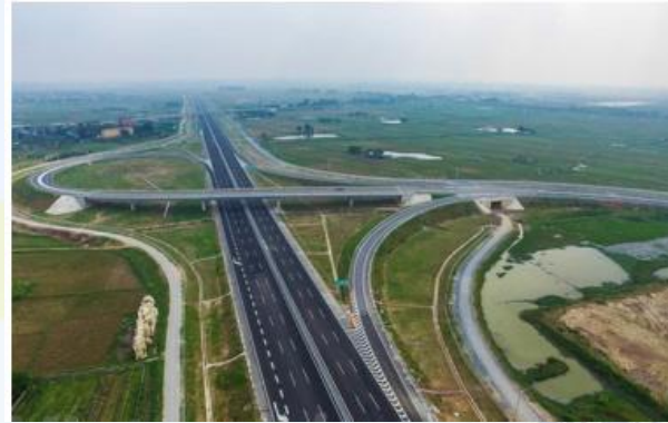
Ha Noi - Hai Phong Highway
